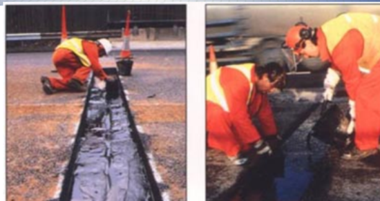
Elastický záливkový mostní závěr firmy REISNER & WOLFF.
