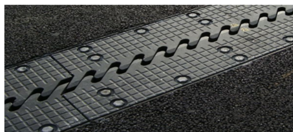
Hřebenový mostní závěr firmy REISNER & WOLFF.
